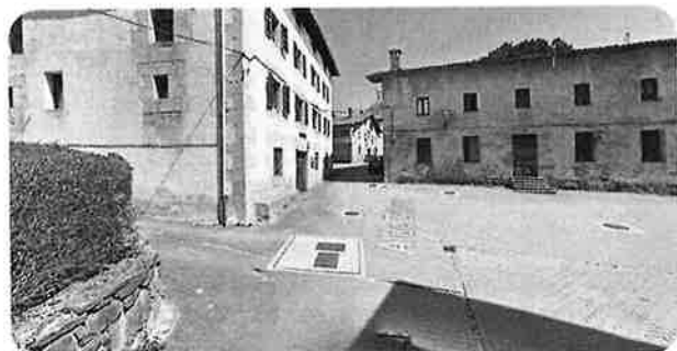
F3: Tramo central de c/Alde Zaharra nº16 conexión con Ayuntamiento
