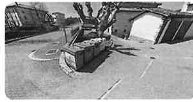
F2.2: paso puente en c/Alde Zaharra nº14-nº3
