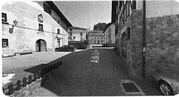
F2: Tramo inferior nº15-nº38 de c/Alde Zaharra nº14
