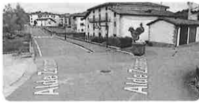
F2.1: paso puente en c/Alde Zaharra nº14-nº3
