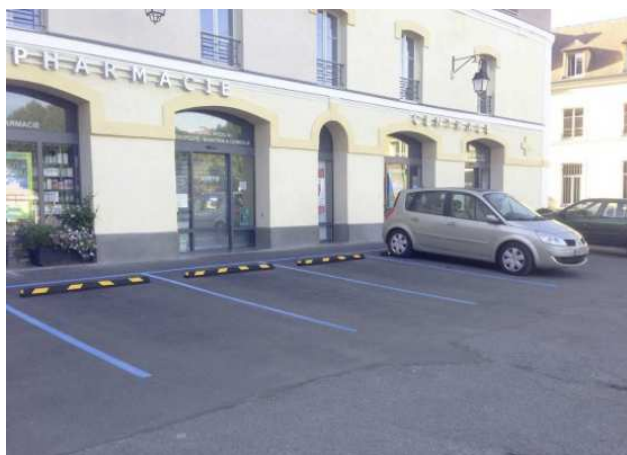
Plazas delimitadas con corredor peatonal entre vehículo y fachada
