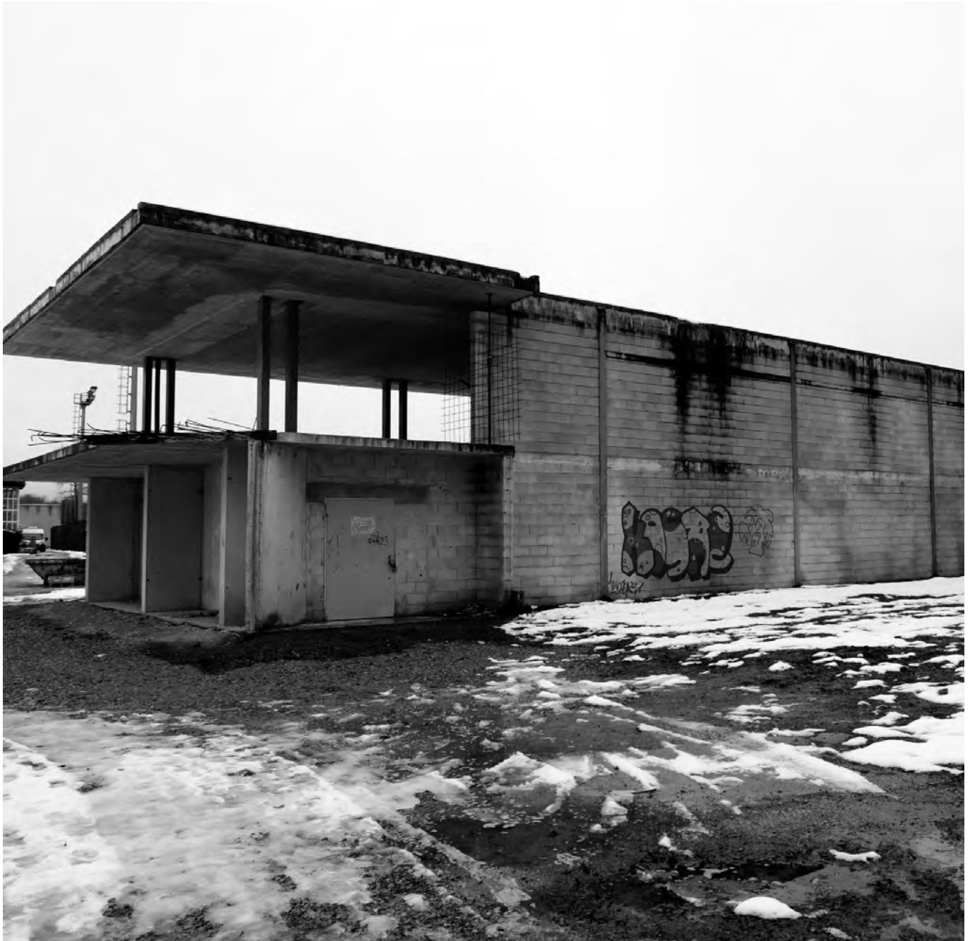
Edificio en construcción. Futuro espacio polivalente. Fuente: propia
