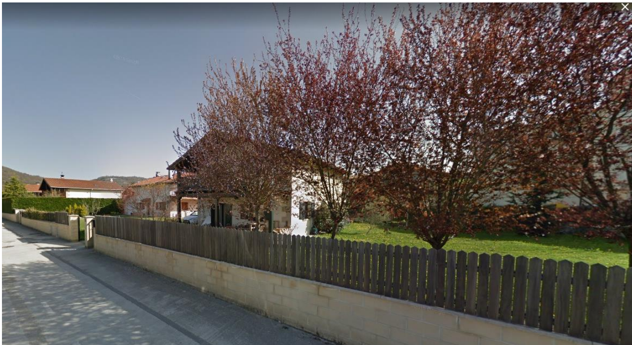
Imagen de los cierres de bloque de la urbanización Katetxiki, ubicada en el ámbito de la Ordenanza O-3
