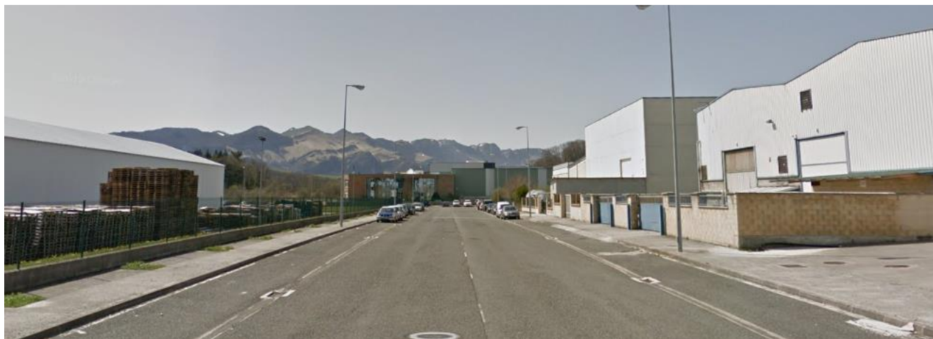
Imagen de los cierres de hormigón (general del polígono) y bloque en el polígono industrial, ubicada en el ámbito O-5
